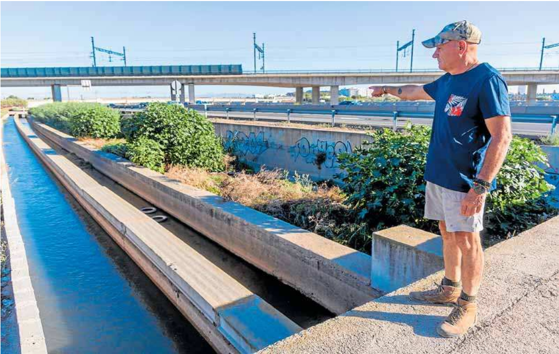
Un vecino de la zona de huerta afectada señala el canal cegado, en la parte derecha y con árboles. JOSÉ LUIS BORT
